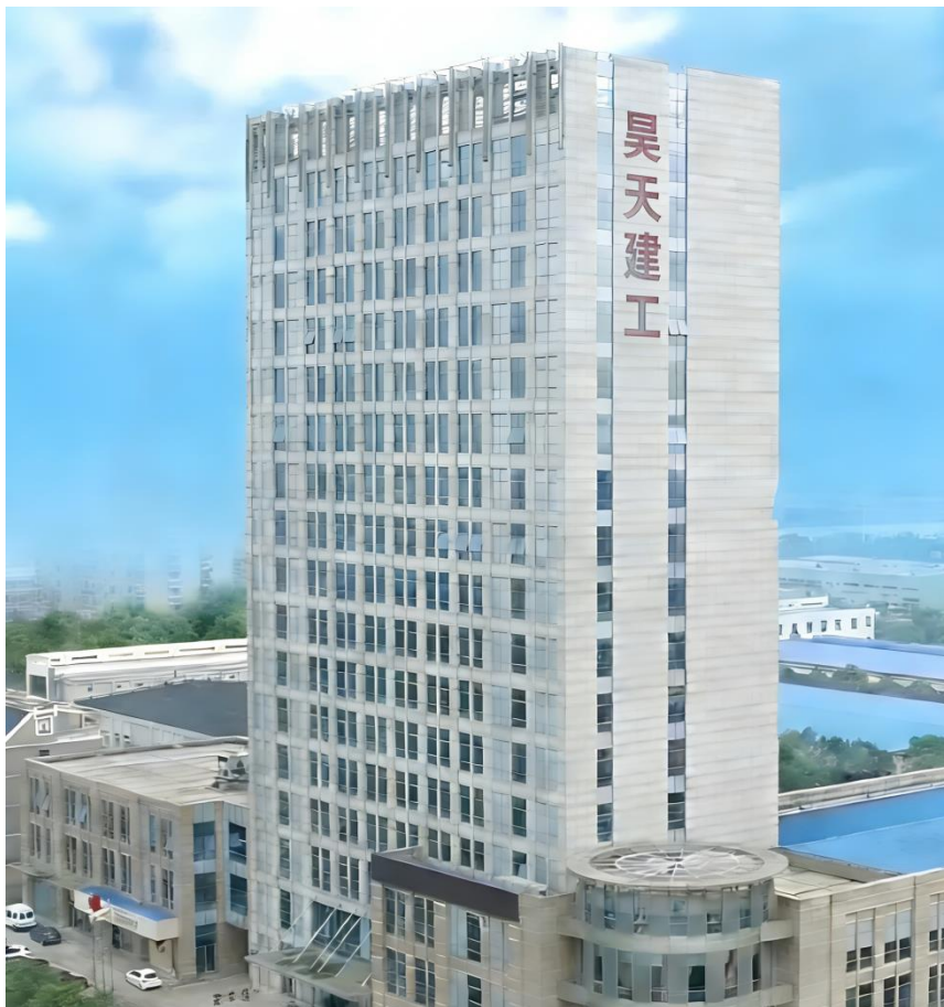
图 1 昊天建工大楼
